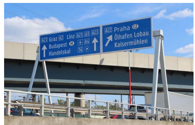
Statische Wegweisung auf einer Flexgantry-Schilderbrücke.
