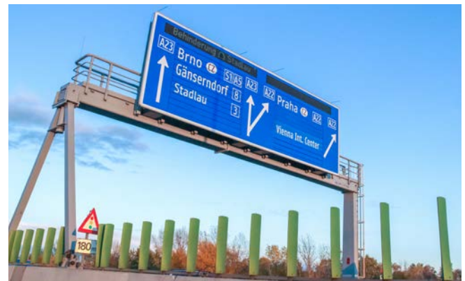
Die Schilderbrücken für die Wechselverkehrszeichen in Prismentechnik wurden für Wartungszwecke begehbar ausgeführt.
