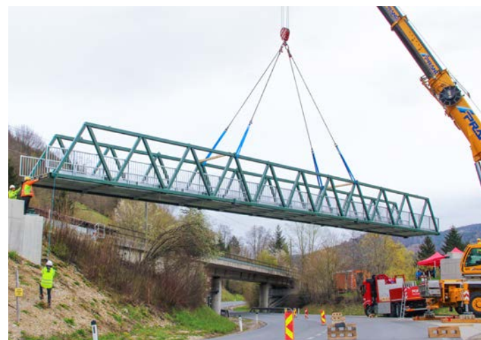
Erfolgreicher Brückenhub für den Lückenschluss des überregionalen Radweges R16.
