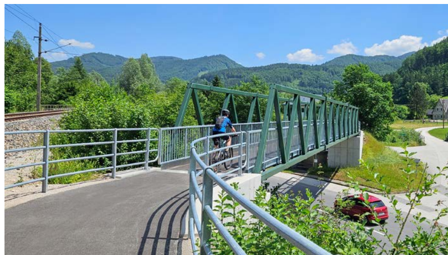
Die Fahrradbrücke ermöglicht RadfahrerInnen eine sichere Querung der Bundesstraße.
