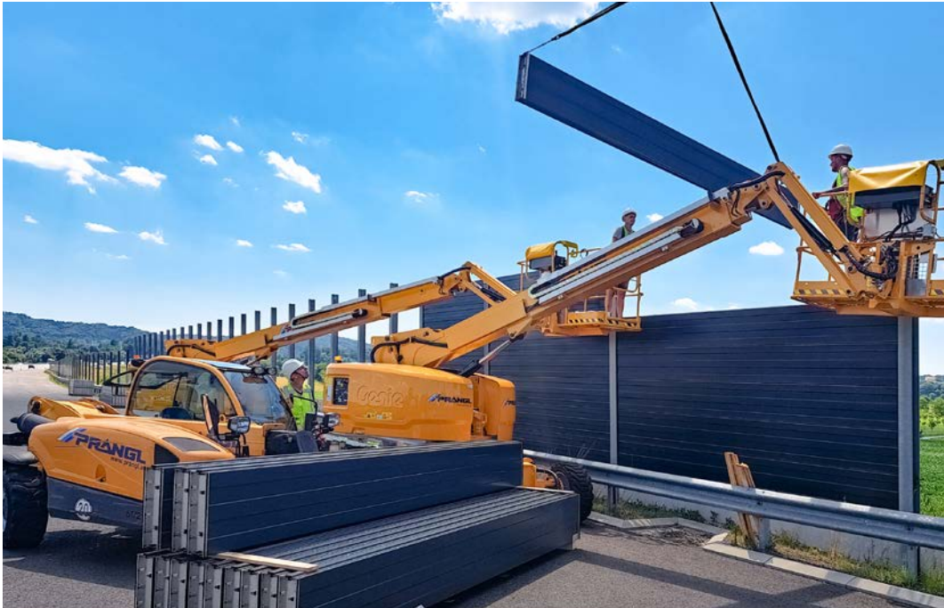
Monteure im Einsatz: Forster wurde auch mit der Lieferung und Montage der Lärmschutzmaßnahmen beauftragt.
