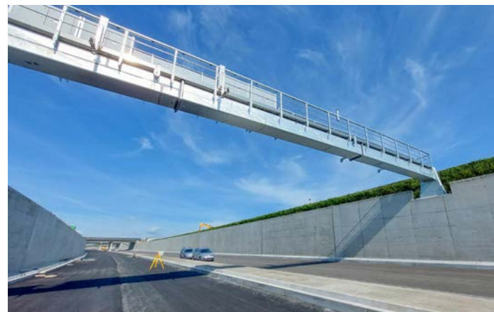
Die Schilderbrücken im Vorportalebereich des Tunnels Rudersdorf sind bereits montiert.
